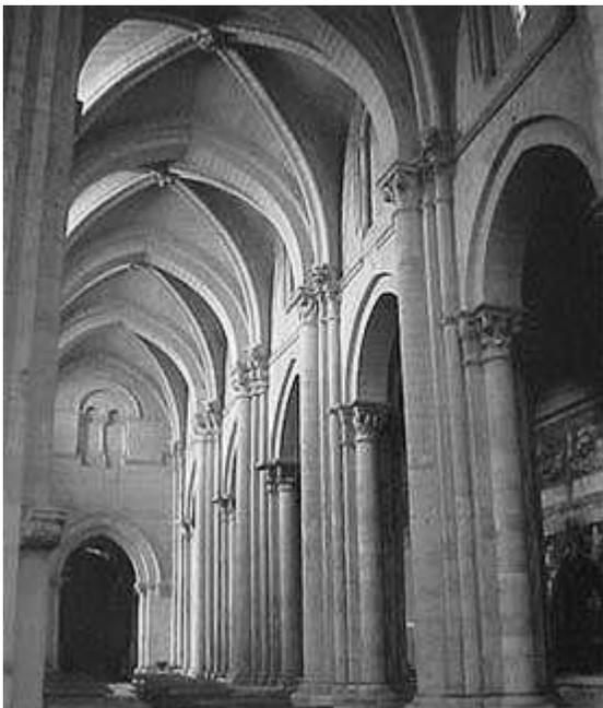
*Bóveda cilíndrica. Los siglos XI y XIII fueron testigos de una intensa actividad en la construcción de iglesias. Al utilizar la forma de la basílica los maestros constructores replazaron los techos planos de madera por grandes cúpulas de piedra conocidas como bóvedas de cañón o bóvedas cilíndricas. Como esta fotografía de una iglesia románica de Viena lo evidencia, la bóveda de cañón limitaba el tamaño de una iglesia y dejaba poco espacio para las ventanas.*
