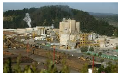
Planta de celulosa
